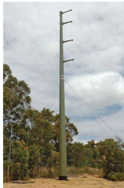
Опора Valmont без металлических траверс в ландшафтно-совместимом исполнении
