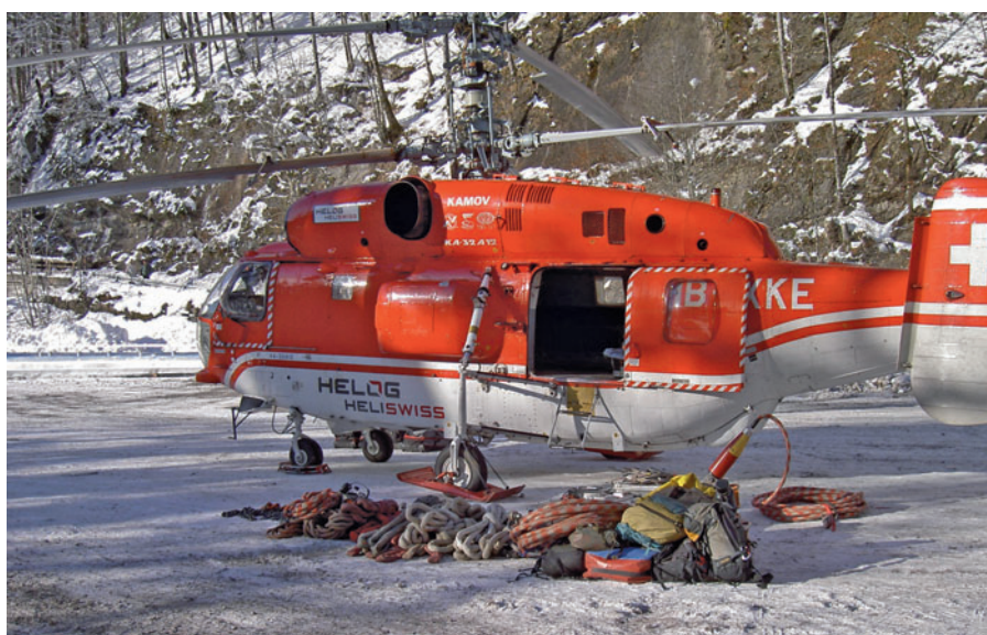
Рис. 9. Применение вертолета Ка-32 в электросетевом строительстве Швейцарии
