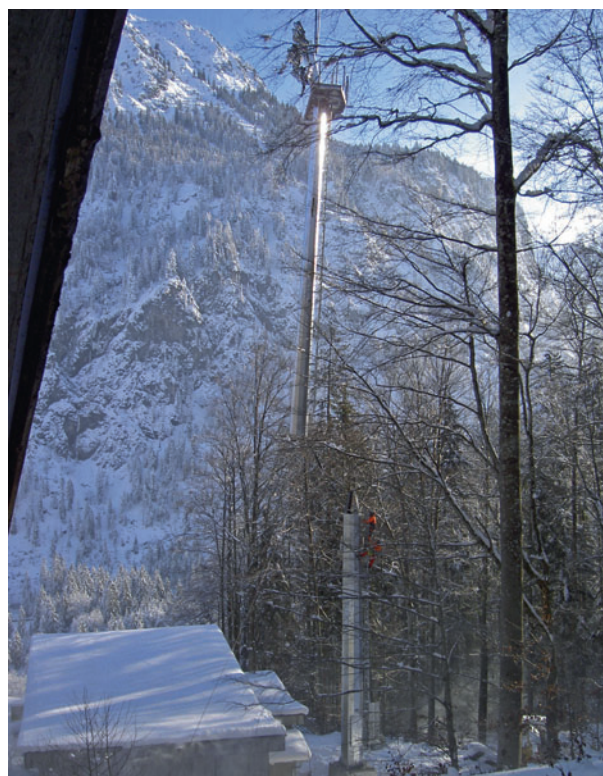
Рис. 11. Монтаж звена опоры
