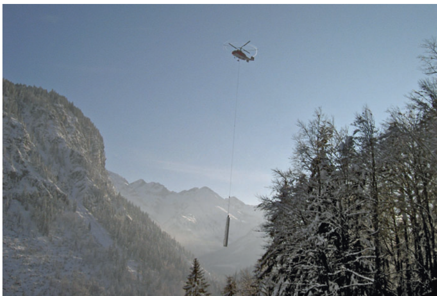
Рис. 10. Вертолет поднимает очередное звено в воздух
