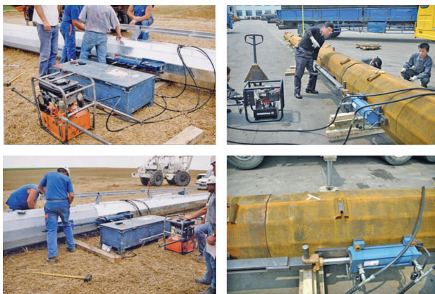
Рис. 8. Соединение секций домкратом
